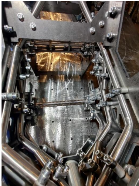
Rysunek 23. Złożone stawowisko z ramą gotową do spawania, widok z przodu [opracowanie własne]
